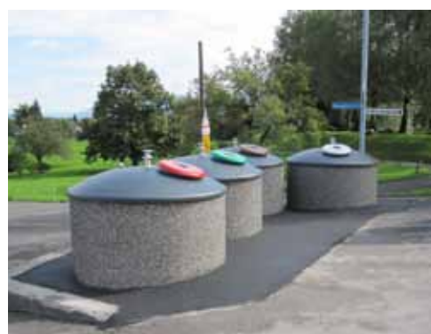
Halbunterflurbehälter in Grabs (Marktplatz).
