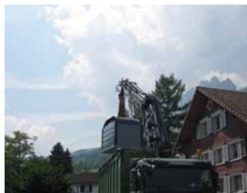
Entleerung neues Containersystem (Sennwald).
